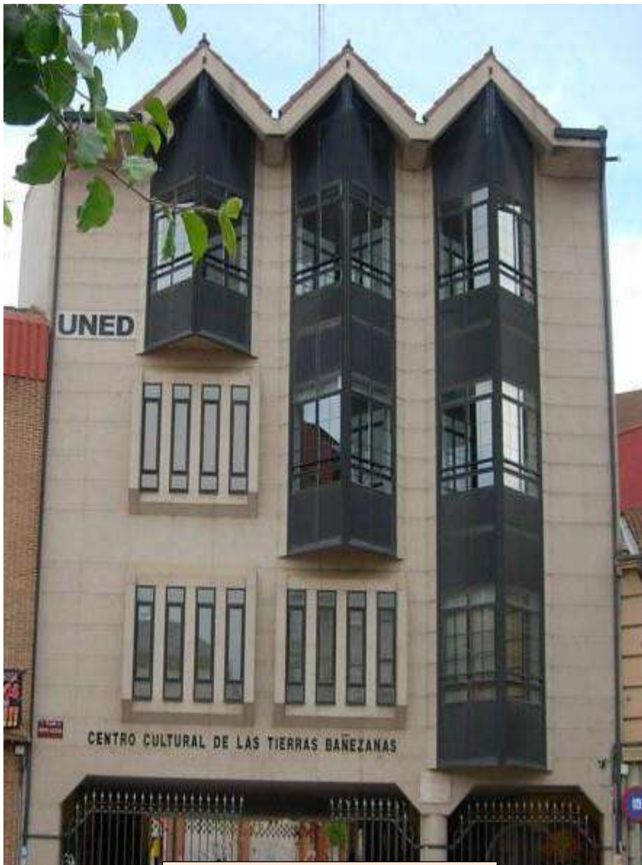
EDIFICIO CULTURAL -TIERRAS BAÑEZANAS- La Bañeza
